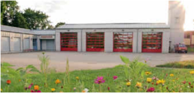
Die neuen Rolltore am Feuerwehr-Gerätehaus.
