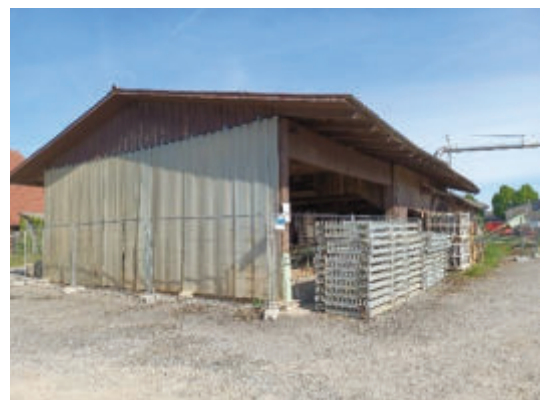
Sägewerk, Blick von Südosten. (PLÖG, 2025)
