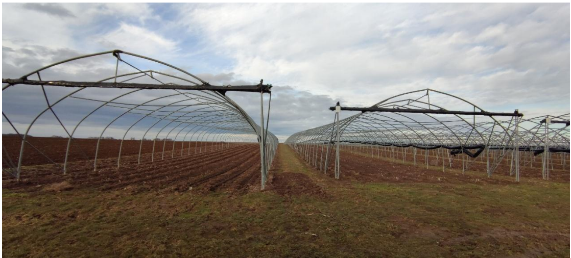
Blick auf das geplante Vorhaben, die Photovoltaikanlage liegt im Wartungstreifen zwischen den Folienzellen und überragt nur unwesentlich die Folienzelle
